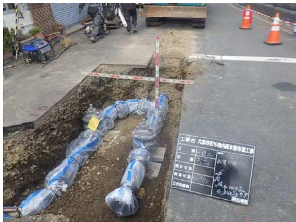
不断水栓【断水せずに既設管の分岐、栓止めを挿入】
