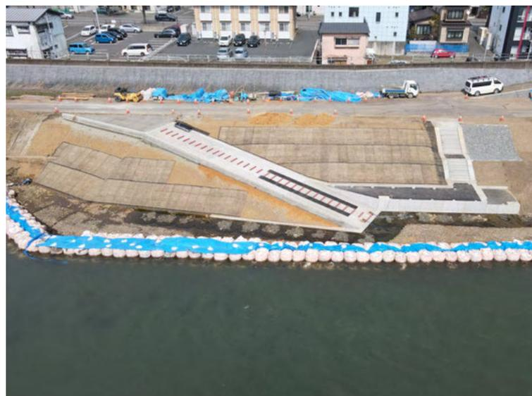
※南大通地区：令和2年度は、堤防天端の舗装と大型土のうの撤去を残して完成です。
